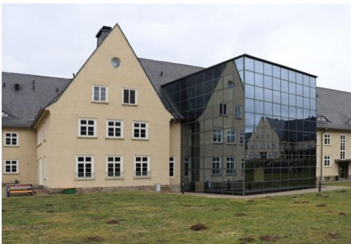
Ein Teil des nordöstlichen Flügels und des Daches war mit einem provisorischen Dachstuhl versehen. Durch den Umbau konnte das ursprüngliche Schieferdach wiederhergestellt und ergänzt werden. Im rückwärtigen Teil der beschädigten Fassade entstand ein moderner dreistöckiger Lehrtrakt mit Vorlesungsräumen. Dadurch stand der Fakultät eine Hauptnutzfläche von mehr als 3.000 m<sup>2</sup> und ein breites Angebot von Hörsälen und Seminarräumen zur Verfügung.
